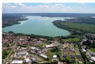
In basso a destra l'impianto di depurazione di Bardello
