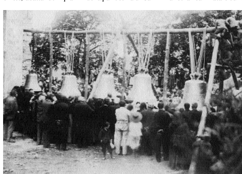
La posa delle campane, 1900 - Collezione Mörzh
