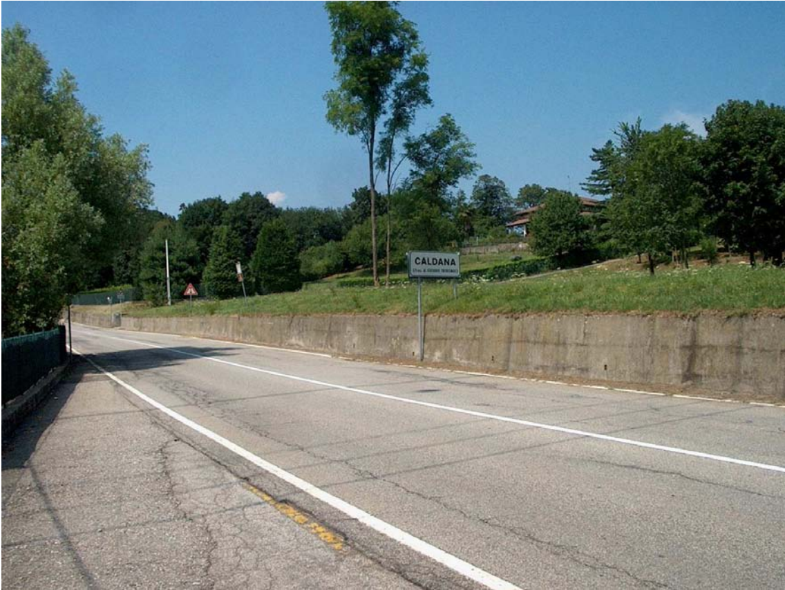
Tratto tra strada privata e cimitero oggetto di sbancamento
